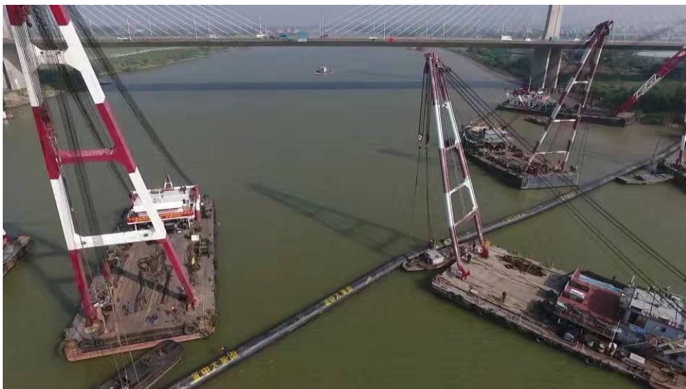
项目预埋管道施工现场图片
