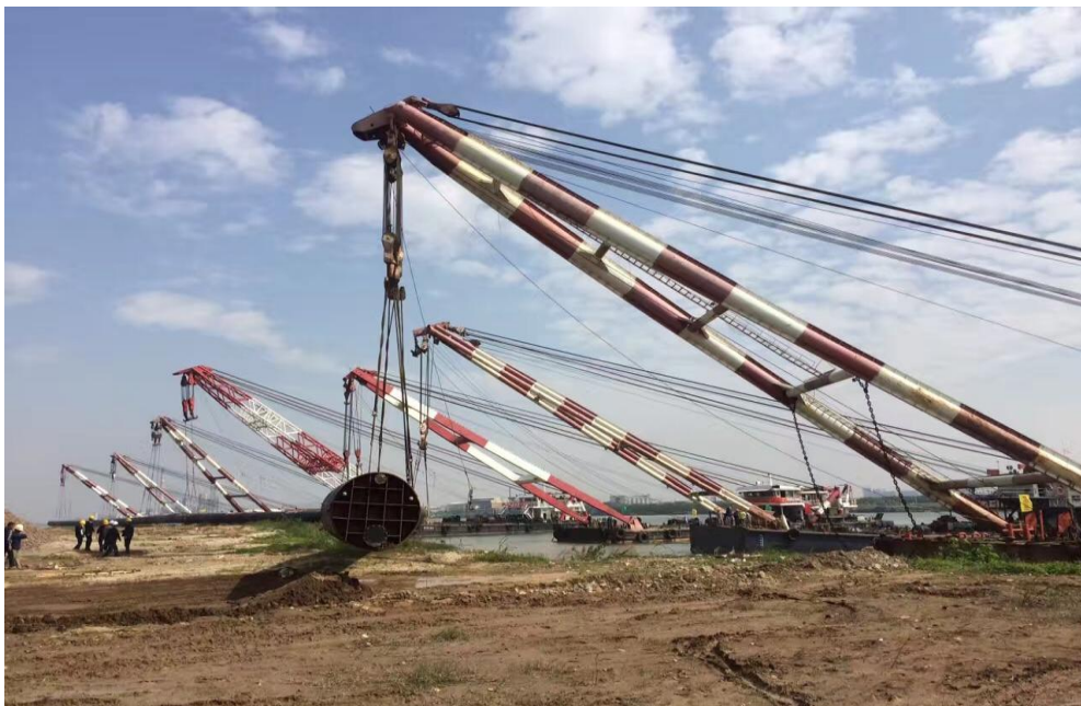
项目预埋管道施工现场图片
