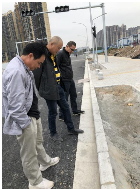
专家在检查滨河路项目
