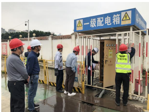
专家们对施工用电进行检查
