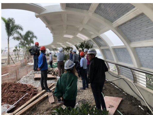
检查施工现场的安全文明施工
