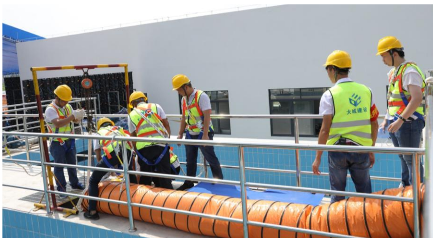
应急抢险组对有限空间进行通风，检测，再下井救援
