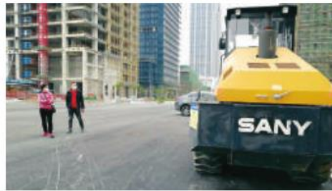
沥青摊铺路段，压路机在作业。
